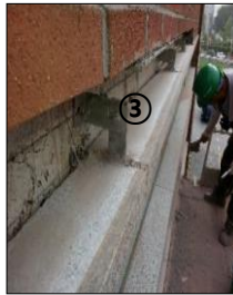
그림2-2 창 상부 철거 사진 및 단면
