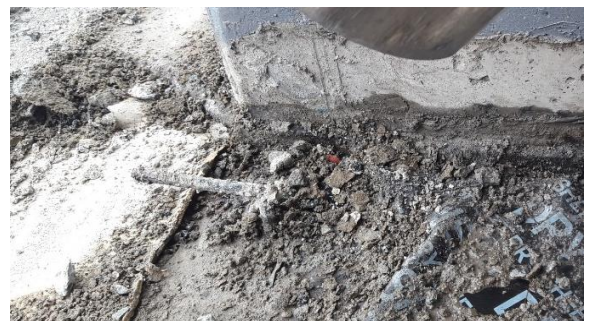
사진4. 지상 1층 주차장 기둥 하부 철거 사진
