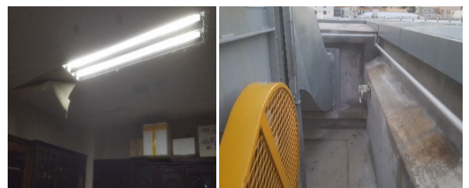
<사진5> 식당 휴게실 천정 및 외부 덕트 사진
