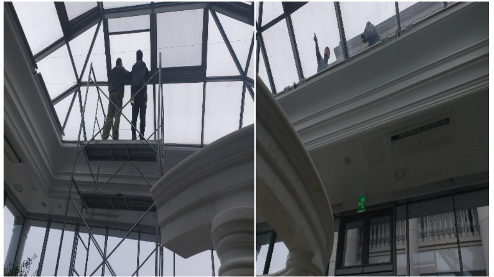
<사진6> 창호 외부 테두리 방수작업 시행 (21/03/15)
