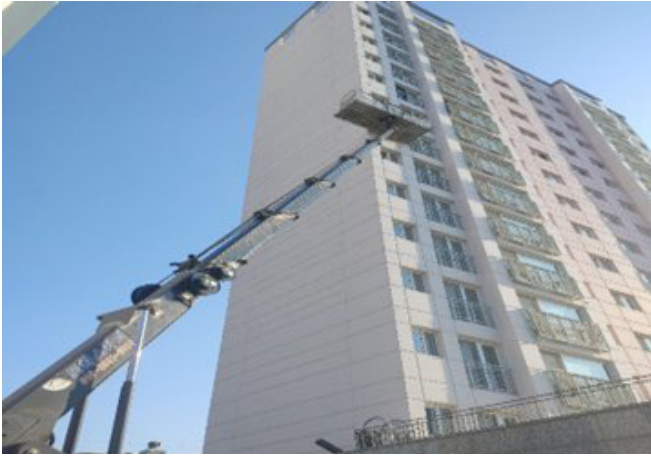
〈사진3〉 어젤리아 신천아파트 외벽 균열 보수 모습
