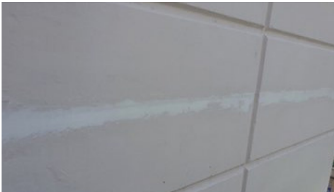
〈사진5〉 어젤리아 신천아파트 외벽 균열보수(중)
